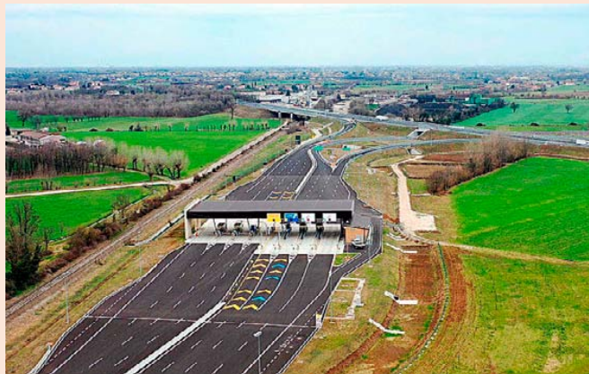
La autopista Pedemontana-Veneta, una de las obras de infraestructura más relevantes en Italia.
