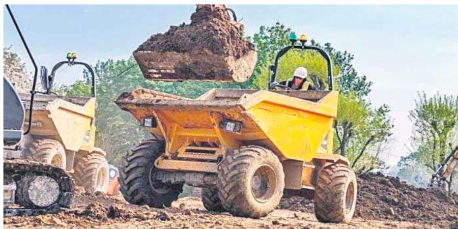
Máquina de tipo 'dumper' parecida a la que ha causado el atropello mortal en Cortegana.
